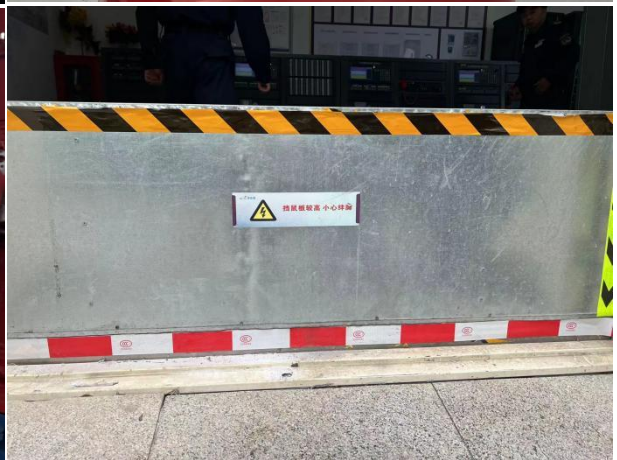
监控画面清晰无损坏，灭火器压力正常 消防泵房干净整洁，门口设有挡鼠板
