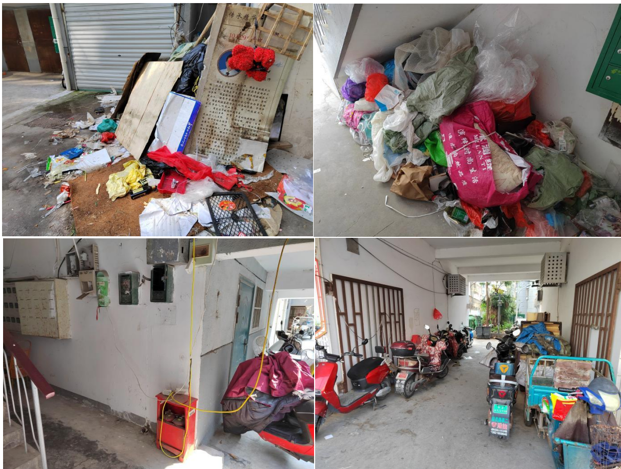
16号楼2单元北侧、1单元楼道杂物堆放
